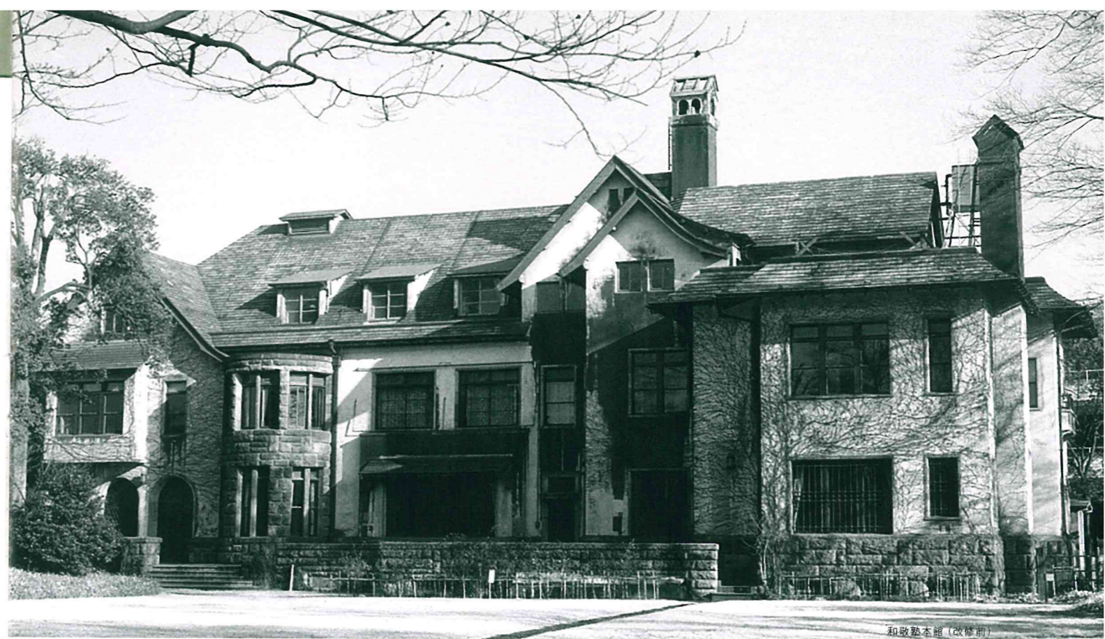
和敬塾本館 (改修前)
